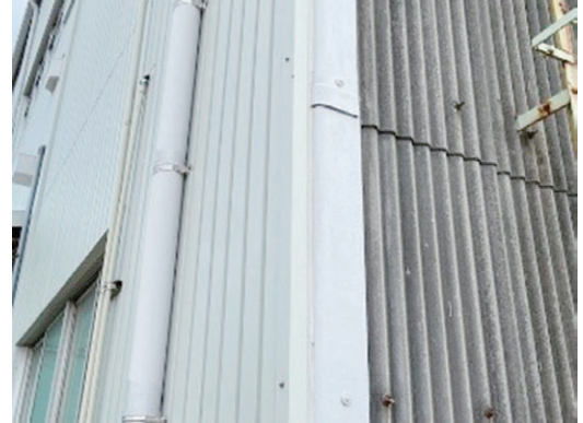
施工壁（左側）と既存壁（右側）
