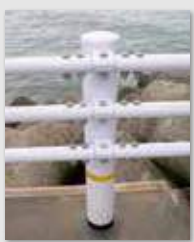
ガードレールの地際防食事例(NPM-A)
