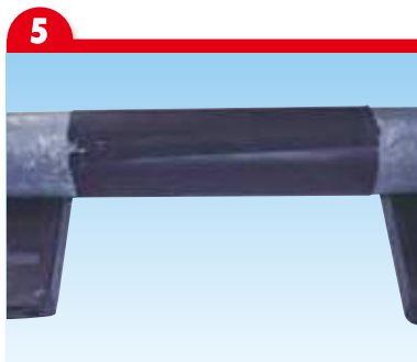
5 保護テープを剥がして完成。
