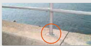
海岸沿いガードレールの地際部防食(NOR-A)
