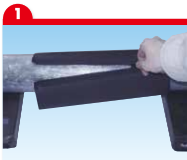
1 チューブを被せ、ジッパーを閉じます。
