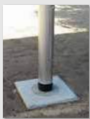
照明柱の地際防食事例(NPM-A)
