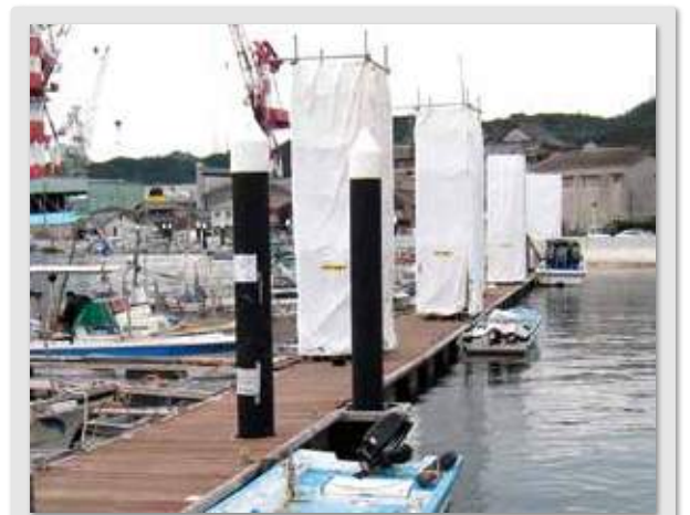
岡山県玉野市係留杭防食補修(NXL-A)
