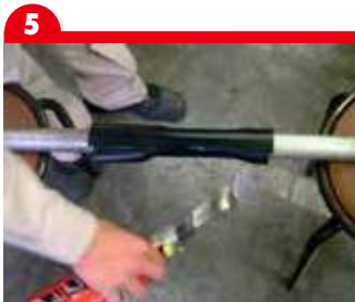
5 使用火枪等加热收缩。 收缩后覆盖的塑胶片撕下也可以。
