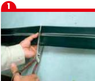
1 剪切下套管需要的长度。
