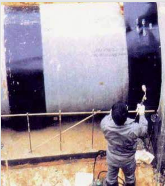
休姆管接头部的防水 NISHI-TUBE (NXL-A)
