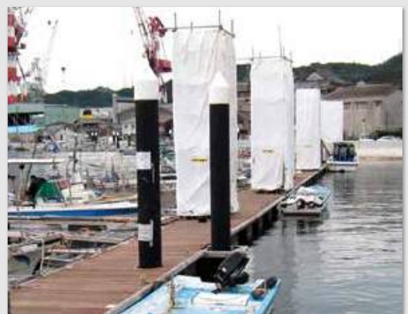
冈山县玉野市停泊码头防锈蚀修补 (NXL-A)
